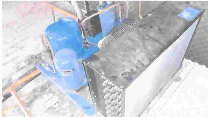
Figura 7: Compresor de cámara de frío ubicado en el segundo piso de las instalaciones de Hielo Cuber.
