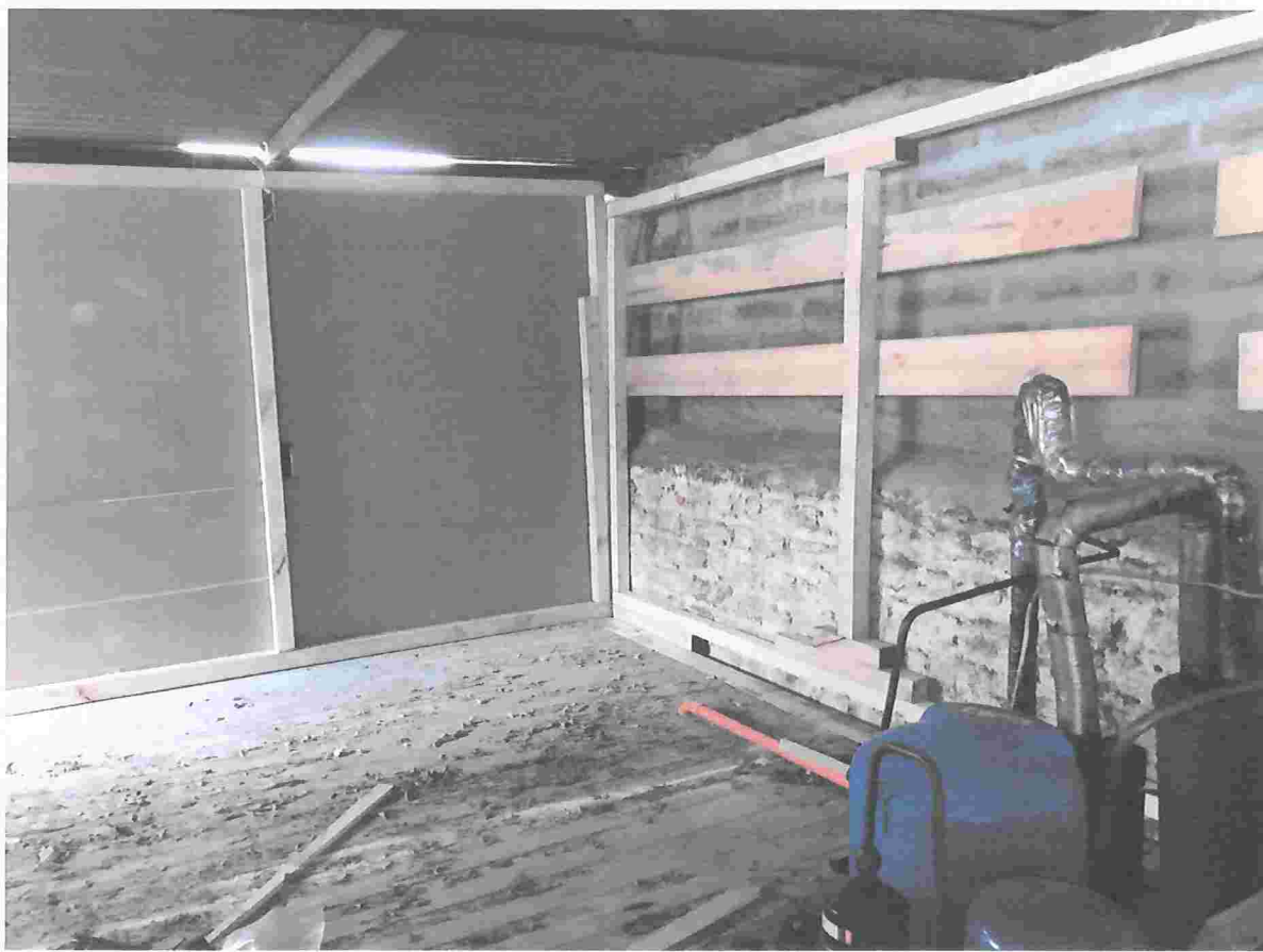
Instalación de tabiquería y paneles de vulcanita.
