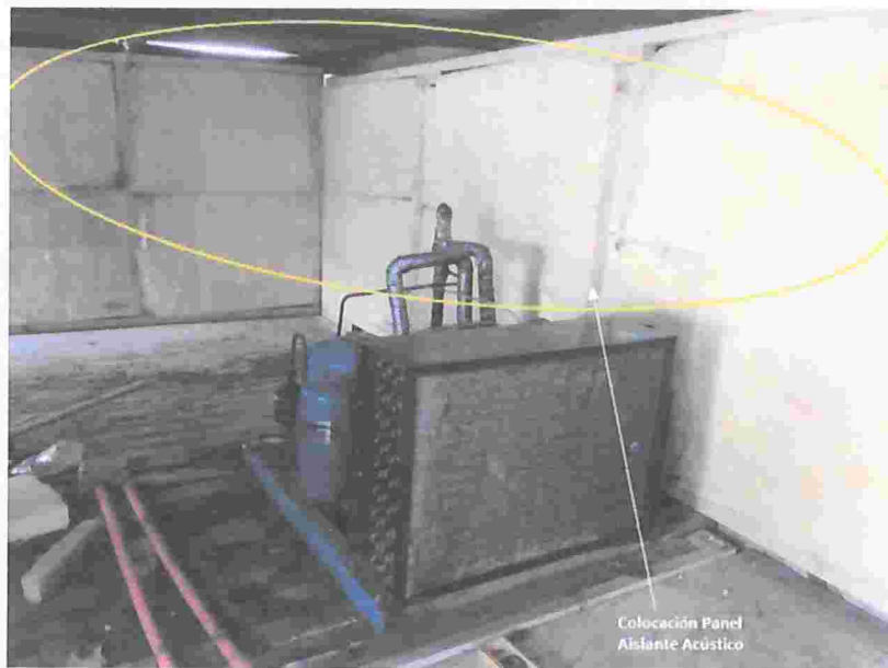
Figura 10: Colocación de panel aislante acústico.
